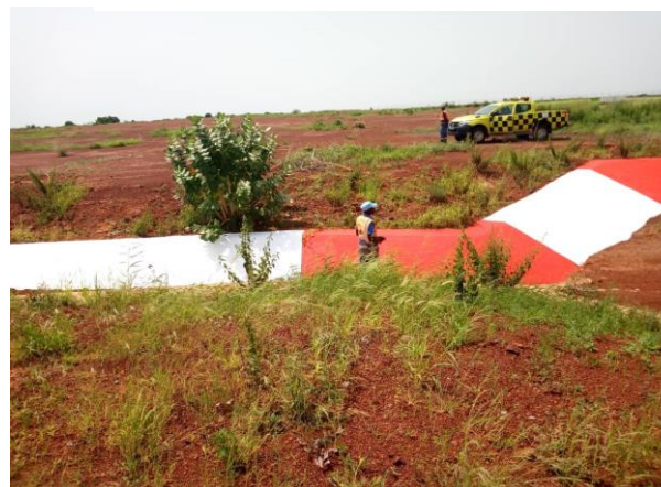
Balisage du canal à ciel ouvert
