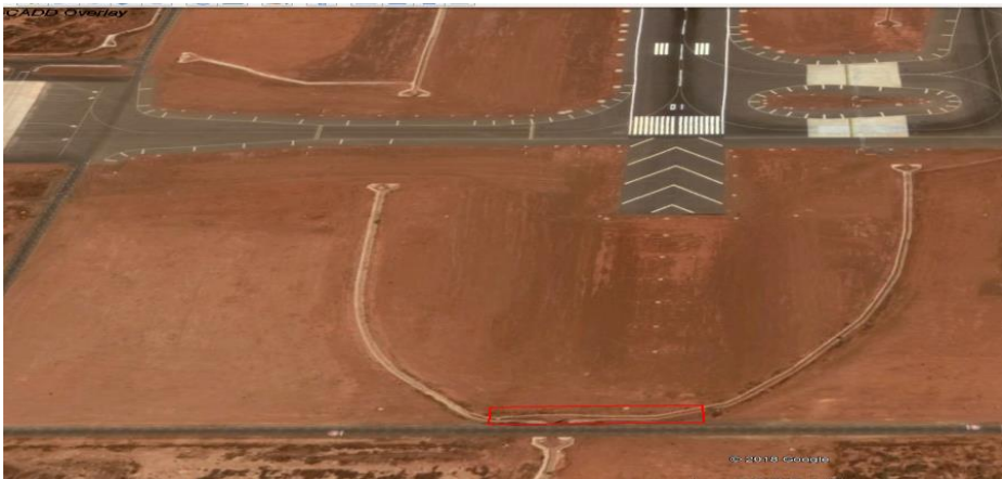
Inexistence d'une voie d'urgence d'accès rapide (présence d'un caniveau à 380 m du seuil 01)
