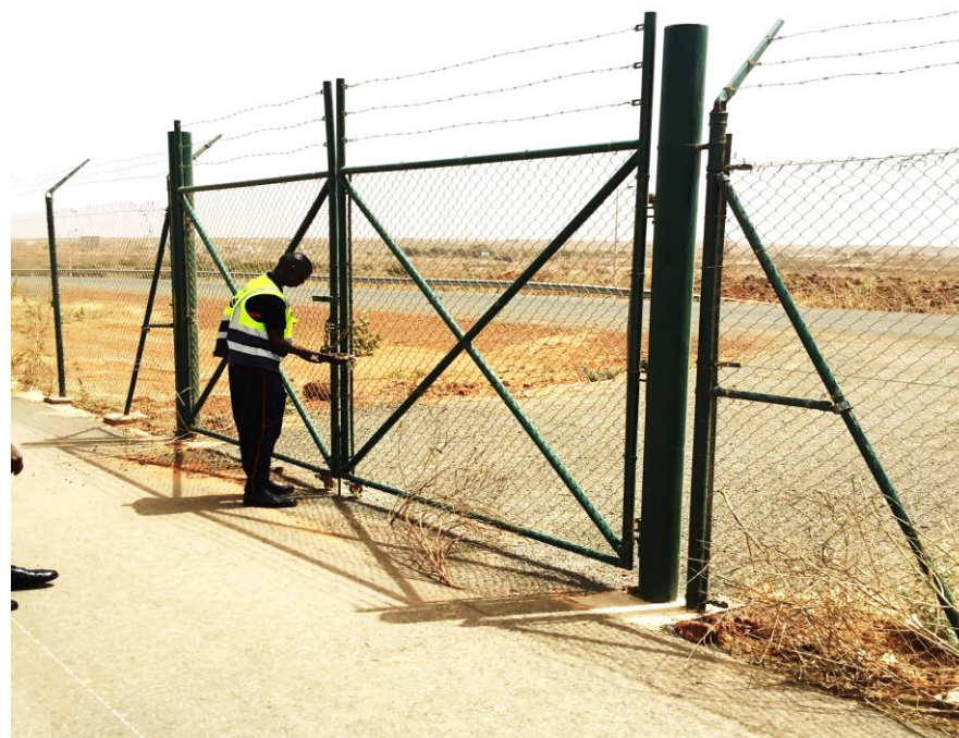
Vérification des portes de sortie d'urgence
