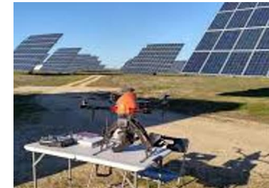
INSPECTION DES INSTALLATIONS ET DES TRAVAUX
