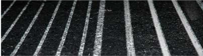
Figura 3. Ranurado lado a lado Normalizadas (Izquierda) y Trapezoidal (Derecha)
