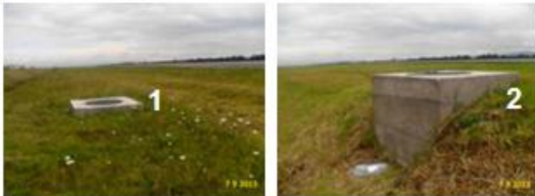
Cajas de inspección y bases de avisos que no están niveladas y algunas cajas de inspección sin tapa.
