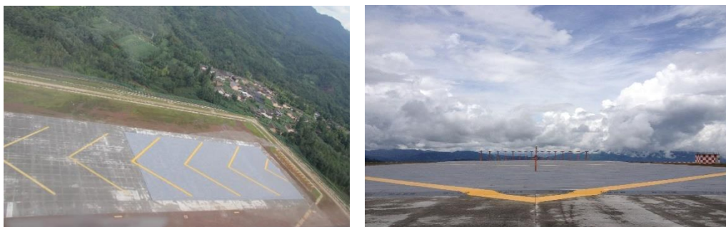
图 2. 腾冲机场Lanzu-1型EMAS系统
