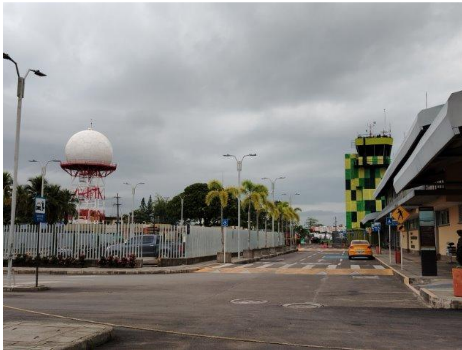
Fotografía. Estación Radar Carepa
