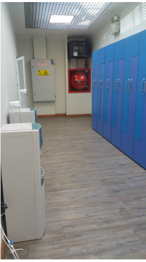
Corredores equipos de emergencia, casilleros
