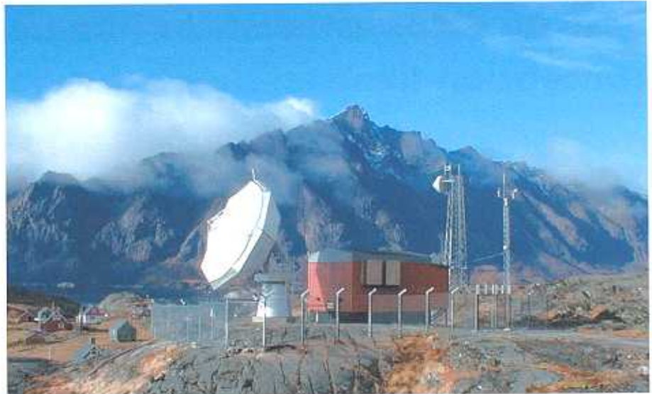
El financiamiento colectivo puede ser apropiado para la infraestructura CNS/ATM.
