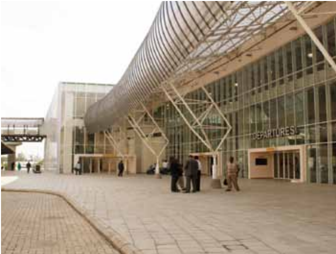
L'aéroport Murtala Muhammad du Nigéria est un établissement de droit privé exploité selon un accord BOT. L'État établit un partenariat similaire public-privé (PPP) pour les autres infrastructures nécessaires.
