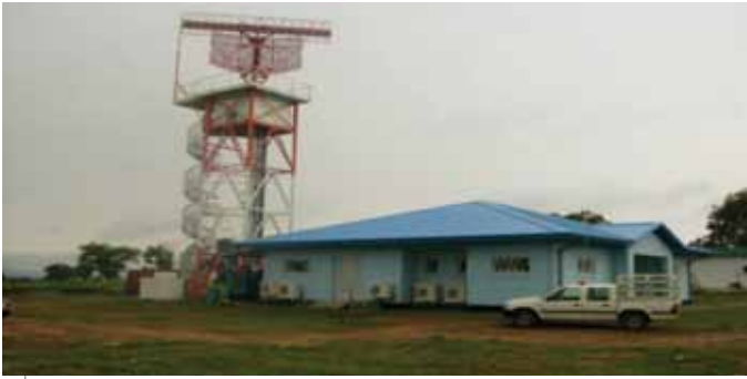
Mise en place récente des installations du projet TRACON permettant d'assurer la couverture radar complète du Nigéria.
