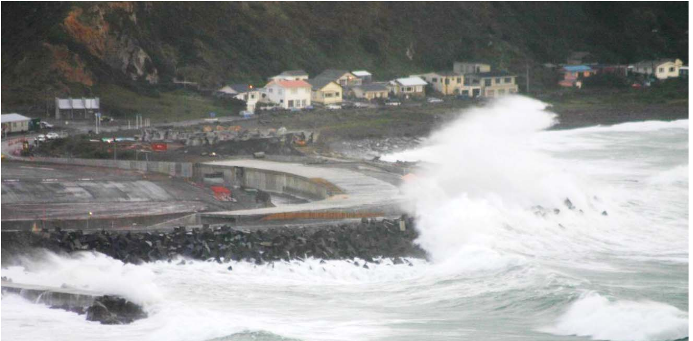
Impact d'un dépôt modéré d'embruns marins sur la nouvelle antenne LLZ de WIA. Jusqu'à présent, les effets des embruns marins n'ont été à l'origine d'aucun arrêt de fonctionnement du nouveau LLZ.
