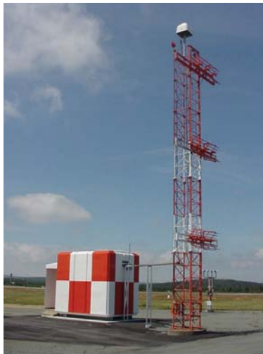
L'inspection en vol d'une installation ILS implique la vérification de l'exactitude des signaux transmis par une antenne de radioalignement de piste (Figure 1, ci-dessus) et une antenne de radioalignement de descente (Figure 2).
