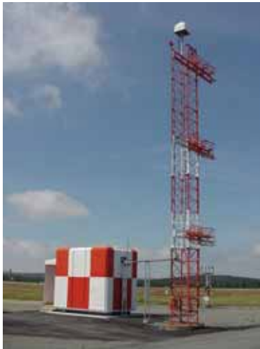
El vuelo de inspección relativo a una instalación ILS entraña verificar la corrección de las señales transmitidas por una antena de localizador (Figura 1, arriba), y la antena dependiente de plano (Figura 2).
