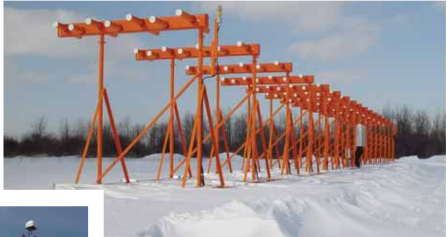
El vuelo de inspección relativo a una instalación ILS entraña verificar la corrección de las señales transmitidas por una antena de localizador (Figura 1, arriba), y la antena dependiente de plano (Figura 2).
