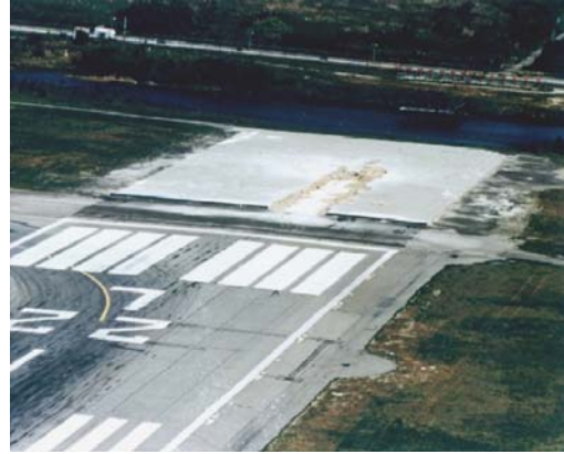
Figura 5 – Fotografías de EMAS a la salida de la Pista 22L en JFK, tomadas al día siguiente en que ocurrió la detención segura de un aterrizaje largo de un SAAB-340 en junio de 1999 (nótese el área de superficie que se retiró para extraer a la aeronave)
