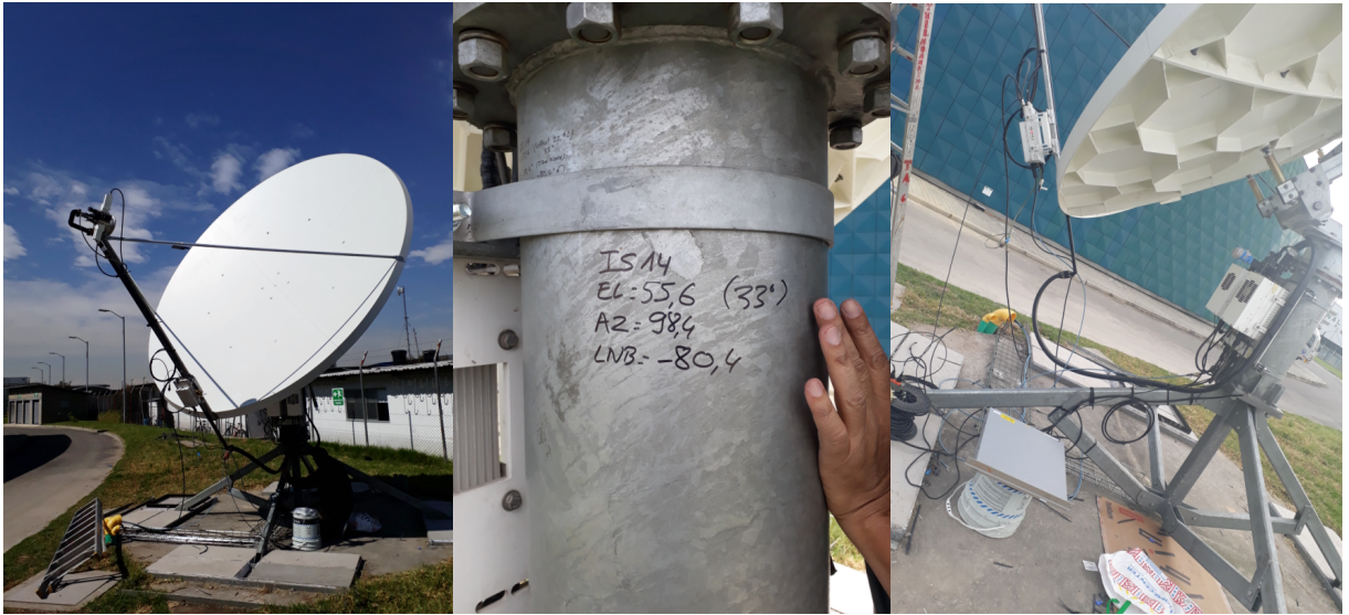
Trabajo en antena nueva
