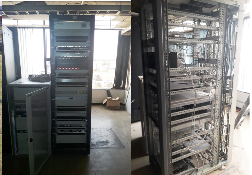
rack con los equipos en instalación del CNA
