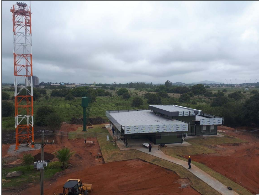
Figura 1 - Instalaciones de la R-TWR Santa Cruz
