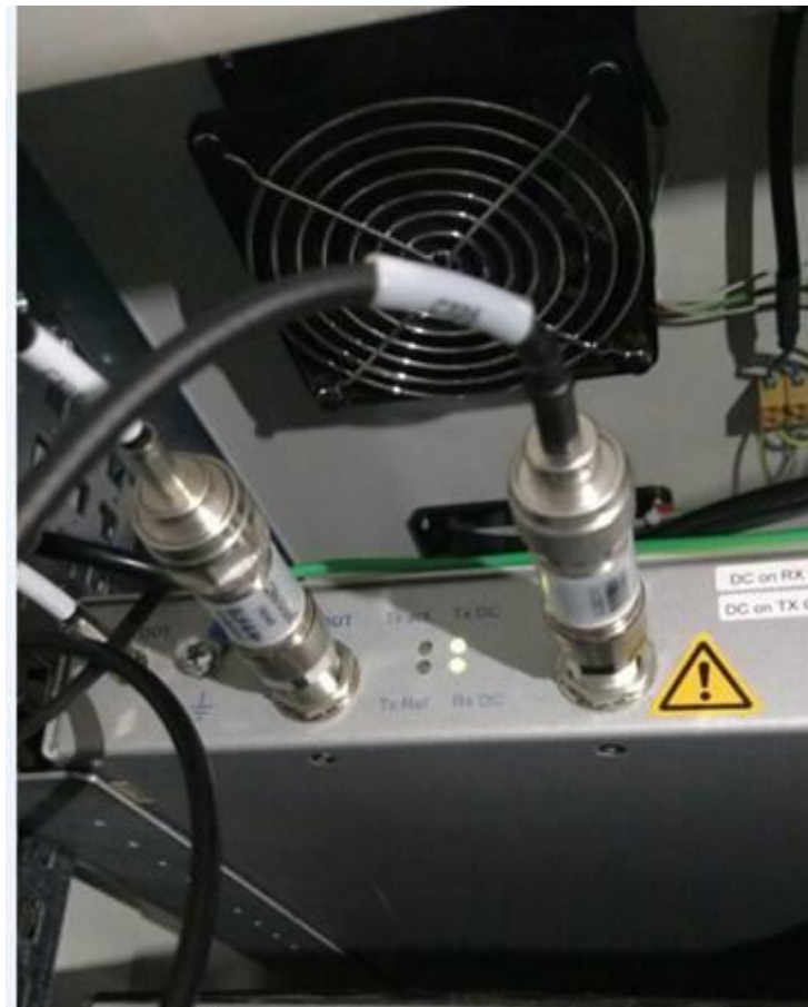
Esta imagen muestra dos DC Blocks en Skywan A
