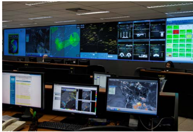
CGNA – Sala de Operaciones
