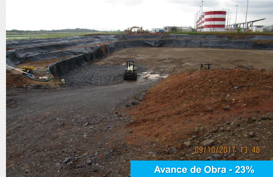
B/.13.5M Construcción de tres tanques (fase 2)
