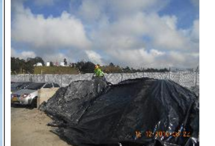
Foto 7 Fecha: 15/12/2016 Descripción: Cubrimiento de materiales acopio principal. Coordenadas: 6°10'22.13"N - 75°25'47.11"O
