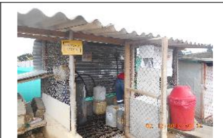
Foto 2 Fecha: 02/12/2016 Descripción: verificación rotulada de sustancias químicas en el acopio e combustible. Coordenadas: 6°10'22.34"N - 75°25'46.68"O
