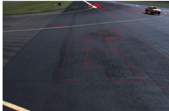
Desprendimiento de agregados
