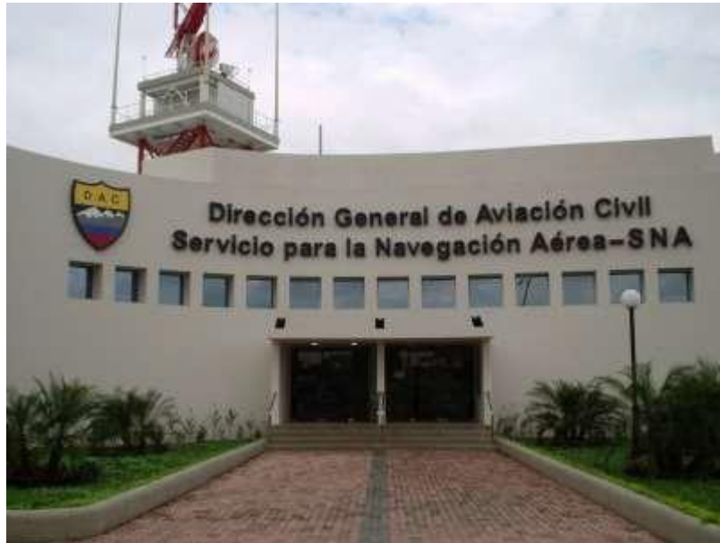
Centro de Control de Área de Guayaquil
