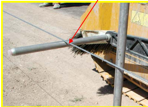
DOS SENSORES COPIANDO NIVEL Y ALINEACION SOBRE EL HILO GUIA, 2 SENSORES A AMBOS LADOS DEL EQUIPO
