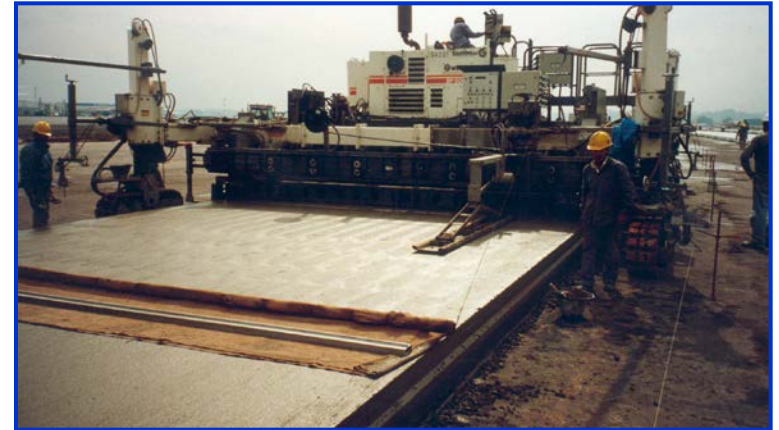
TERMINACION SUPERFICIAL DE CALZADA
