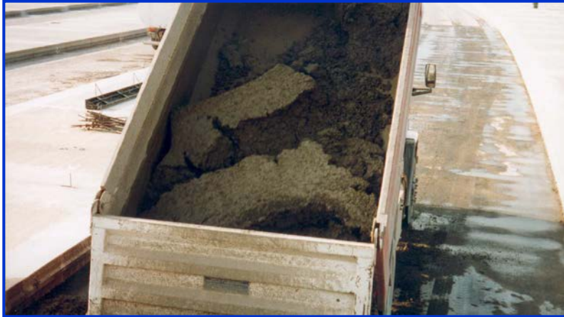
DESCARGA DEL CONCRETO
