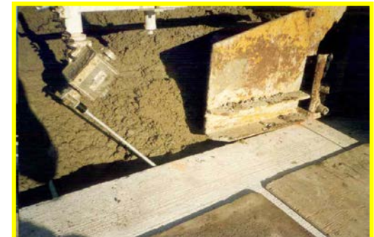
SENSOR COPIANDO NIVEL SOBRE CALZADA EXISTENTE
