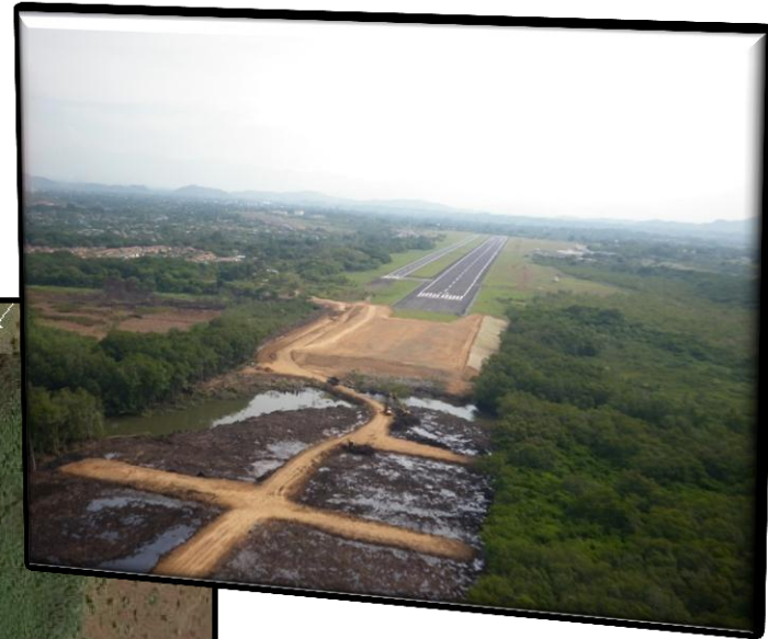
ZONA DE AMPLIACIÓN DE PISTA
