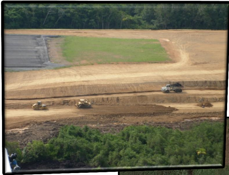
TERRAPLEN DE LA EXTENSIÓN
