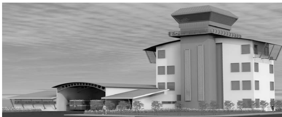
Edificio Torre de Control y SEI
