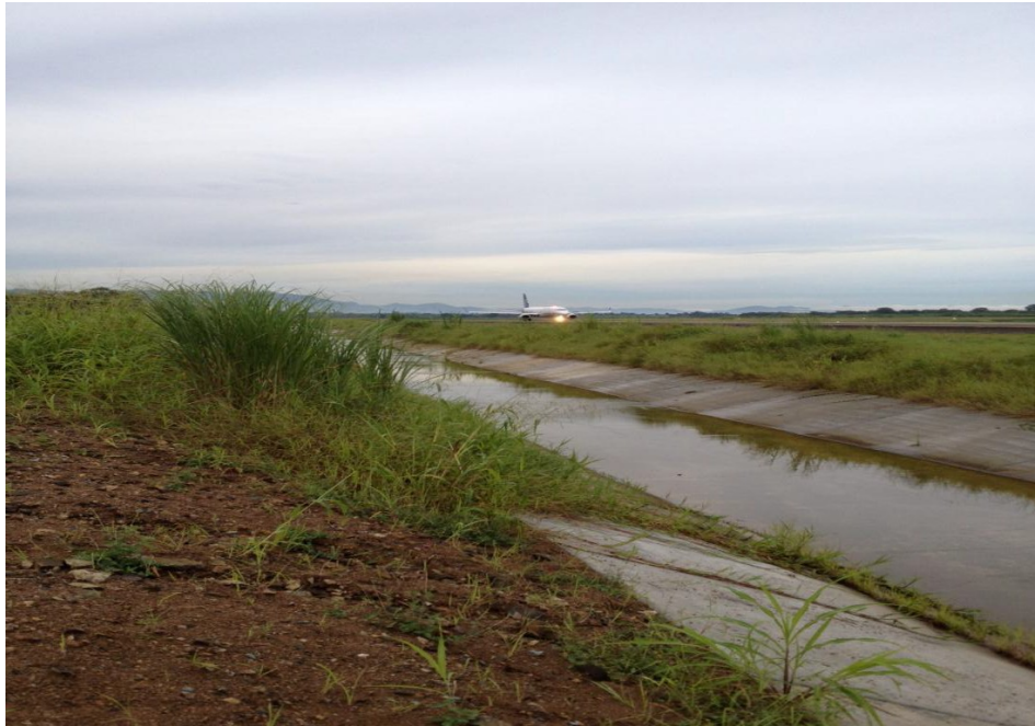
Canal de concreto cercano a la pista
