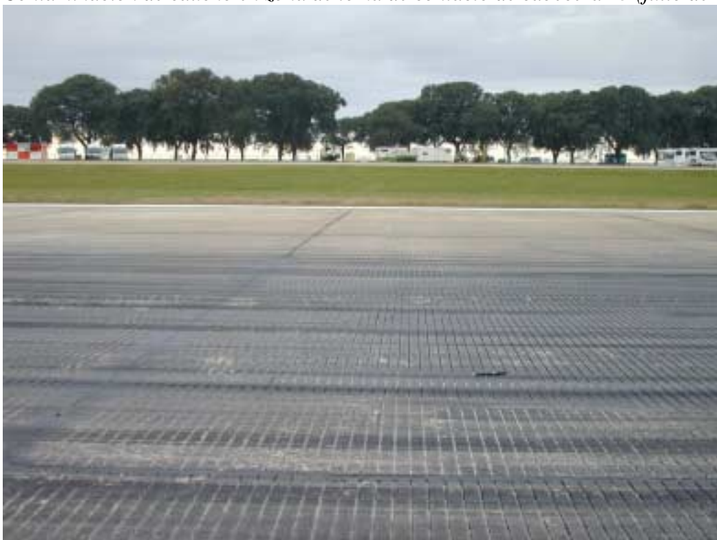
Contaminación de caucho en zona de toma de contacto de cabecera 13 (julio de 2002)
