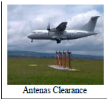
Figura 2. Sistema de Antenas ILS/SENDA DE PLANEEO END FIRE Watts Antenna
