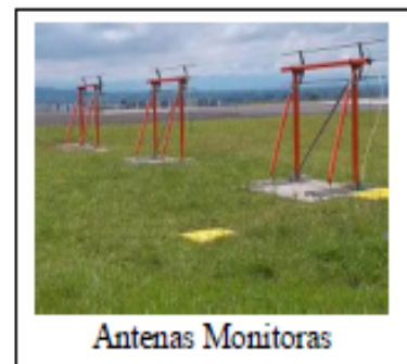
Figura 2. Sistema de Antenas ILS/SENDA DE PLANEEO END FIRE Watts Antenna
