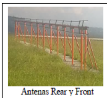
Figura 2. Sistema de Antenas ILS/SENDA DE PLANEEO END FIRE Watts Antenna
