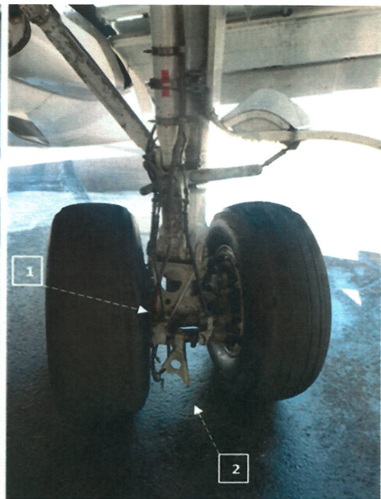
Tren Principal Izquierdo, 1 Torsion Link superior fracturado, 2 Torsion Link inferior fracturado
