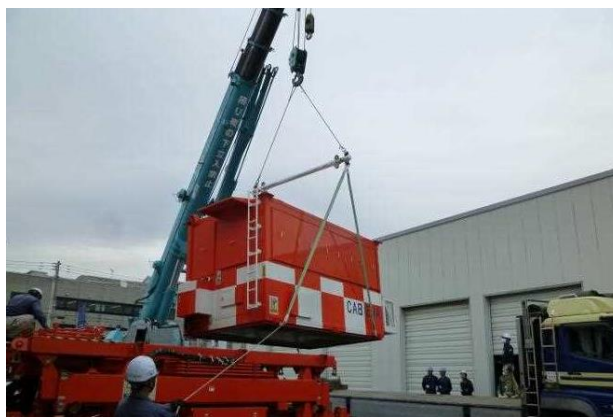
[Mise en place de l'équipement EVA]
