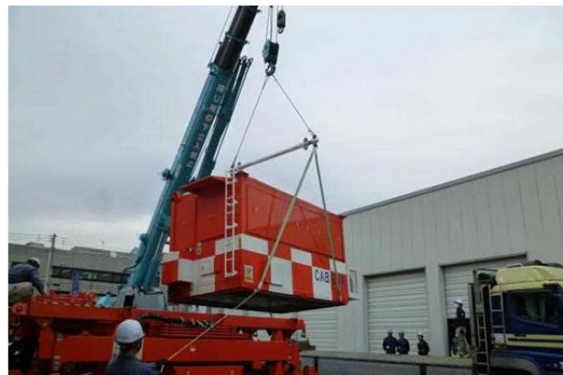
[Mise en place de l'équipement EVA]
