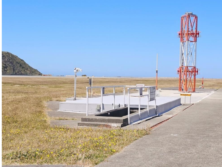
WLG - Glidepath Bunker
