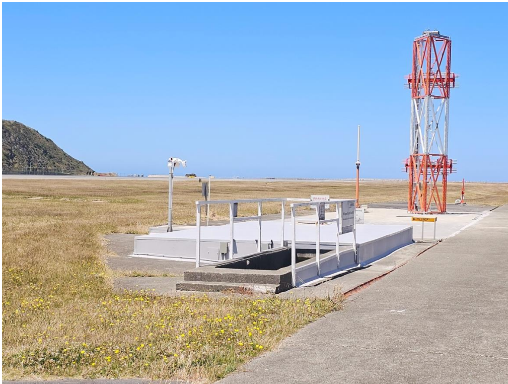
WLG - Glidepath Bunker
