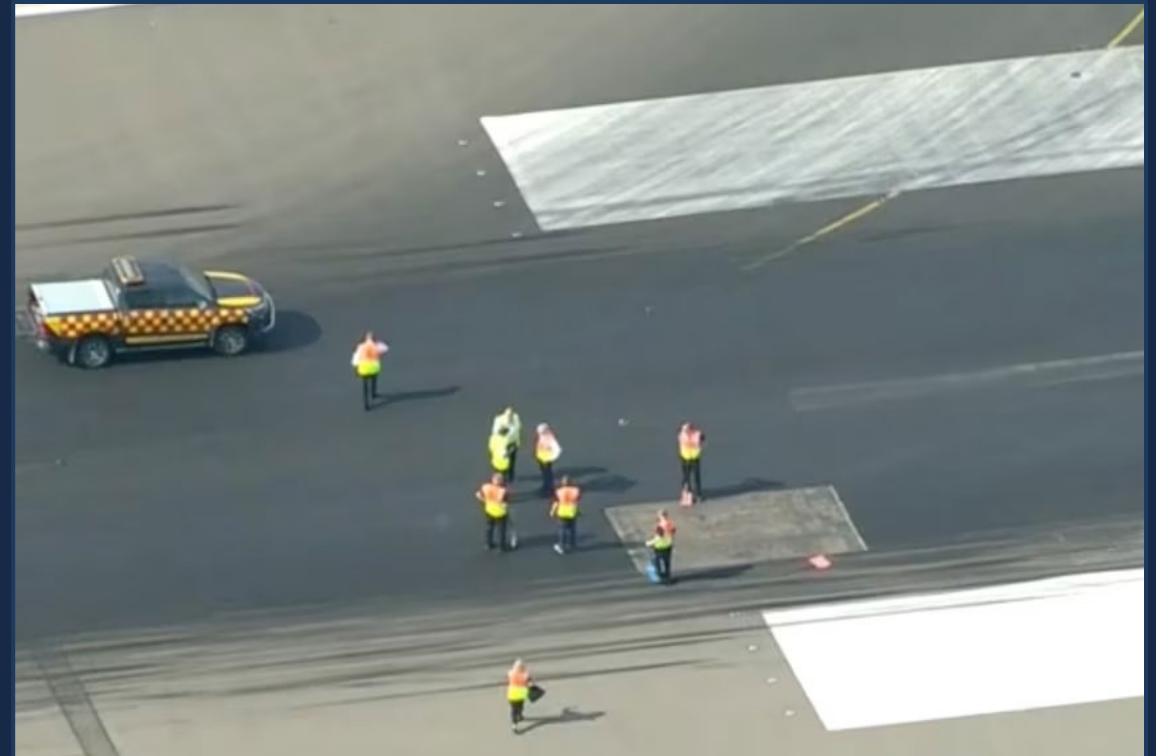
Reparación de pavimento tras daños por calor extremo — Aeropuerto de Heathrow, Londres (ola de calor de julio de 2022)
