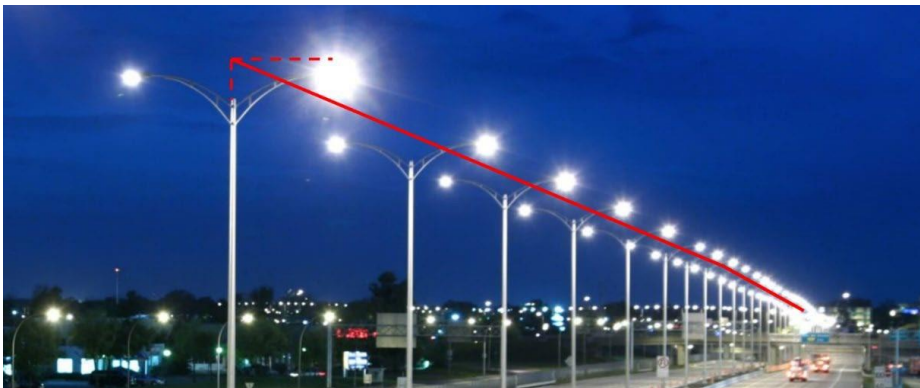
Figure A8: Capture de lampadaires le long d'une autoroute sous forme de ligne
